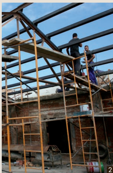
1- Reparacions a la coberta. 2- La futura sala d'exposicions temporals, en construcció.
