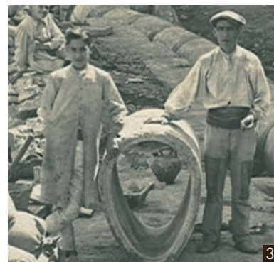
2 i 3- Obres de canalització del clavegueram, 1917-1918. ACBE. Fons Emili Casas. Autor Emili Casas.
