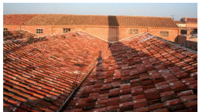
Teulats ja consolidats i rehabilitats.
