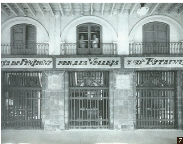
Façana exterior de la primera sucursal de la Caixa de Pensions a la Bisbal obra de Rafel Masó, 1935. ACBE. Col·lecció ACBE. Autor Brangulí Fotògrafs.
