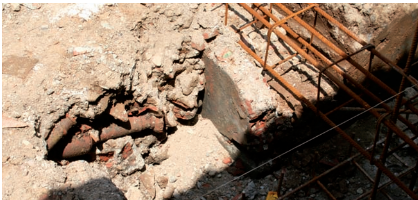
Descoberta de balustres durant els treballs de rehabilitació de l'edifici del Museu.
