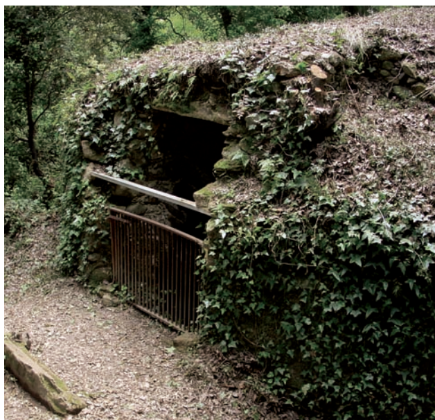
Pou de glaç de la font d'en Salomó. Detall de la porta d'empouar amb la pedra topall pels carros. Fons del Consorci de les Gavarres.
