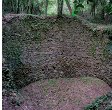
Pou de glaç descobert de la font d'en Salomó. En el perfil es veuen els encaixos de la bastida utilitzada en la construcció. Fons del Consorci de les Gavarres.
