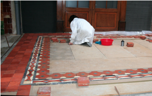
Treballs de muntatge de l'exposició permanent. Paviments de rajola fina.
