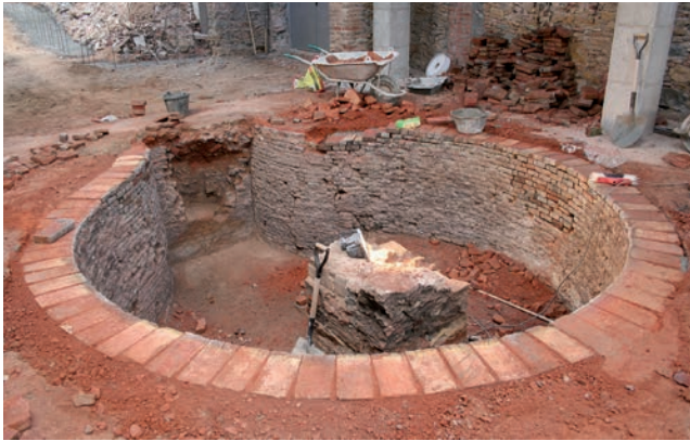
El forn ja excavat i en procés de consolidació i restauració.
