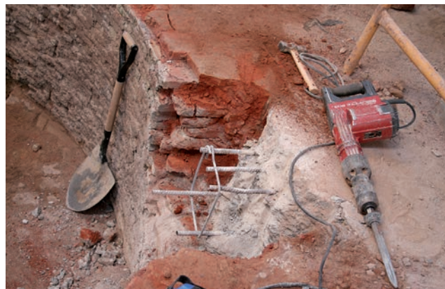
Enderroc d'una de les riostes modernes amb martell mecànic.
